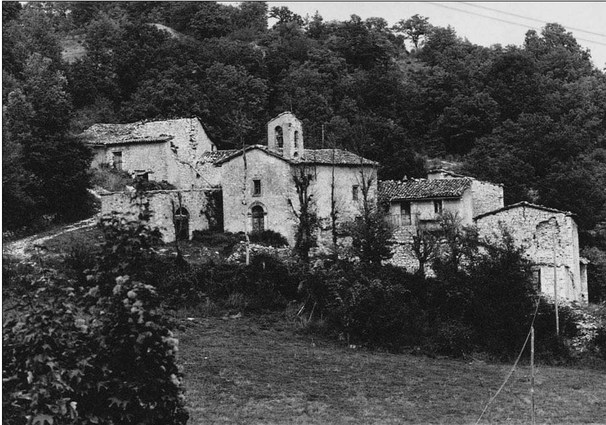
Fig.98 Fiano d'Abeto: alcuni crolli parziali nelle parti alte degli edifici del paese per il terremoto del 19 settembre 1979.
