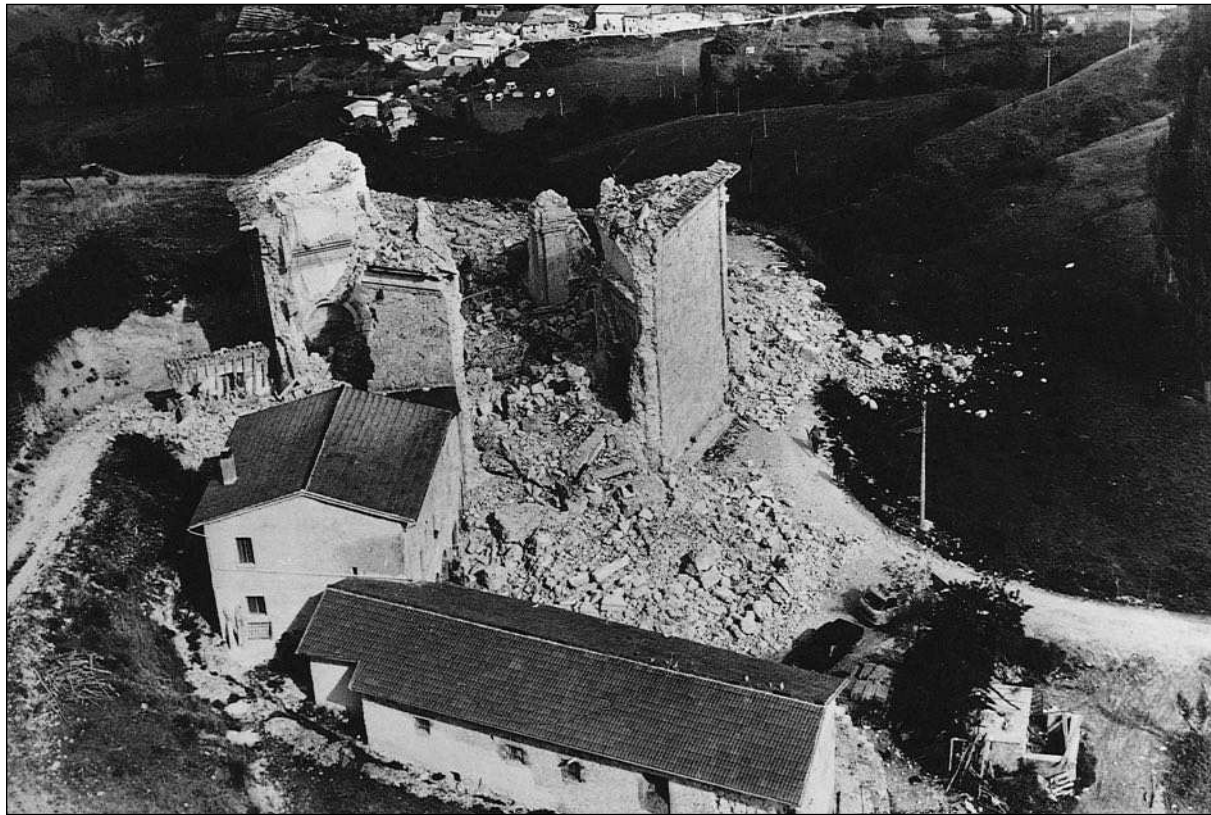
Fig.96 Santuario della Madonna della Neve (nei pressi di Cascia): crollo a causa del terremoto del 19 settembre 1979.
