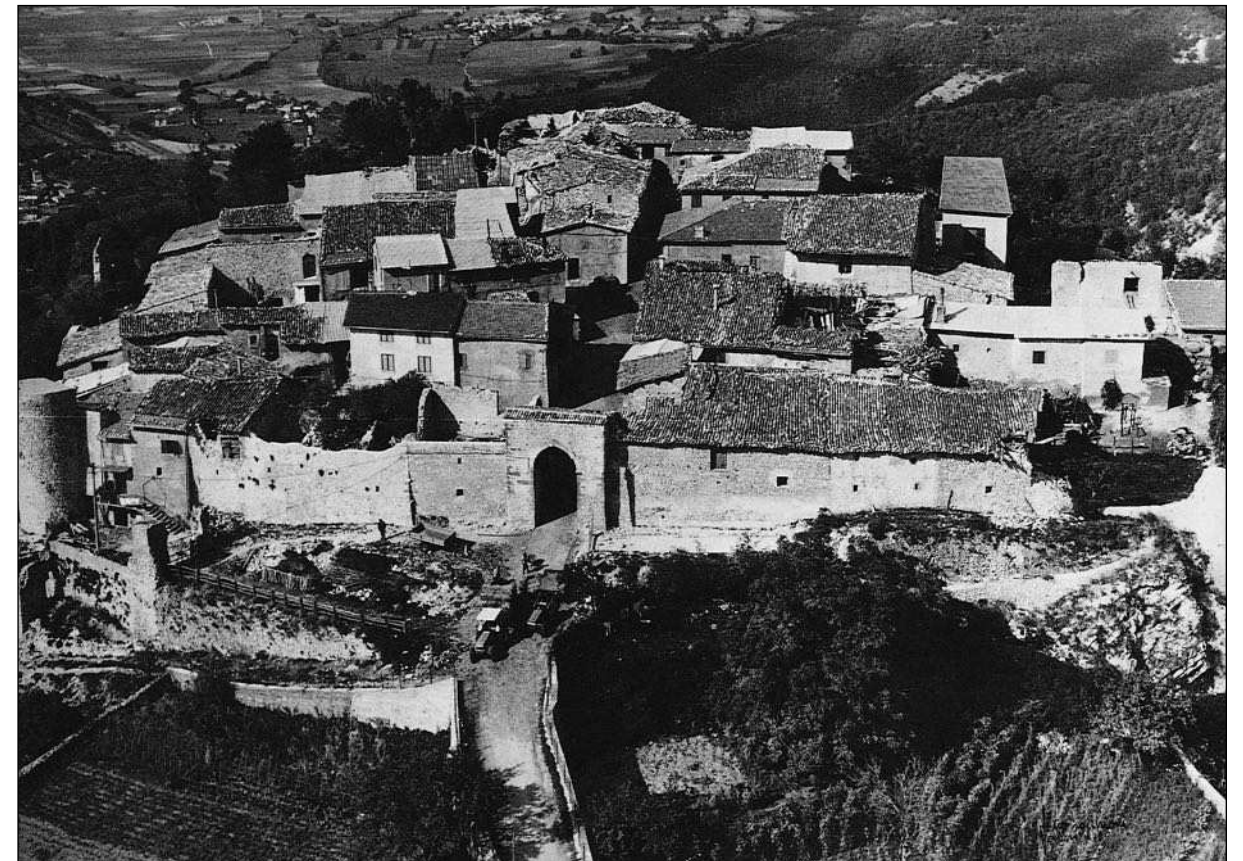
Fig.91 San Marco: danni causati dal terremoto del 19 settembre 1979.
