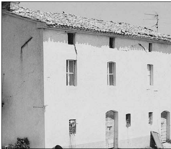
Fig.106-109 Campagna di Gubbio: tipologia di danni nell'edilizia rurale causati dal terremoto del 29 aprile 1984.
