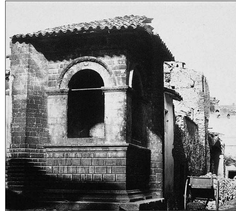
Fig.79 Norcia, casa Cipriani danneggiata dal terremoto del 1859, in una fotografia di Robert Macpherson: in primo piano il tempietto quasi intatto su uno sfondo di edifici crollati (Biblioteca Civica di Storia dell'arte “Luigi Poletti” di Modena, Fondo Poletti).
