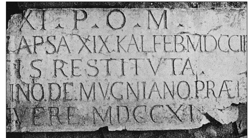
Fig.24 Norcia: Castellina, particolare dell'epigrafe, un tempo conservata sulla porta Santa Lucia, in cui si ricorda il restauro avvenuto dopo il terremoto del 1703.
