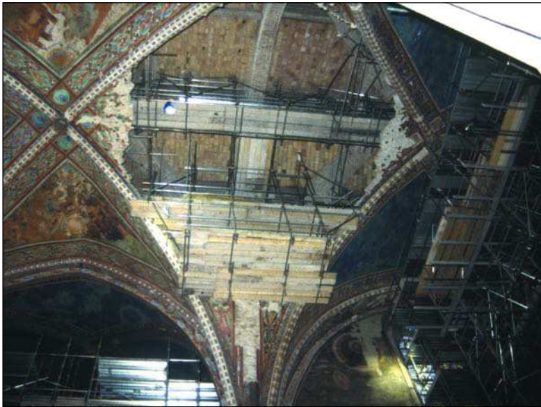
Fig.121 Assisi: Basilica Superiore. Il grande crollo messo in sicurezza
