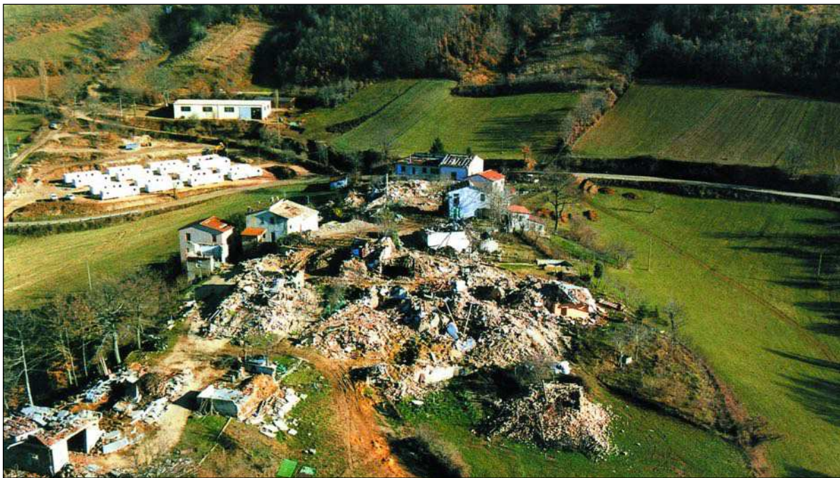
Fig.112 Collecurti (Serravalle del Chienti): l'abitato devastato dal terremoto.
