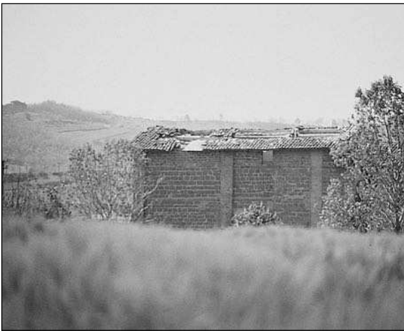
Fig.106-109 Campagna di Gubbio: tipologia di danni nell'edilizia rurale causati dal terremoto del 29 aprile 1984.
