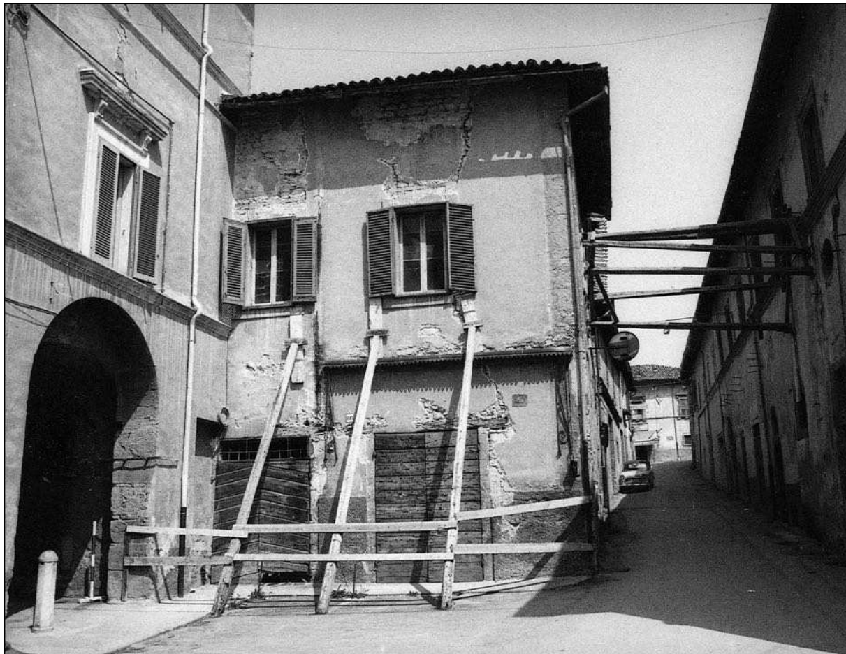
Fig.92 Norcia: case puntellate in via Anicia dopo il terremoto del 19 settembre 1979
