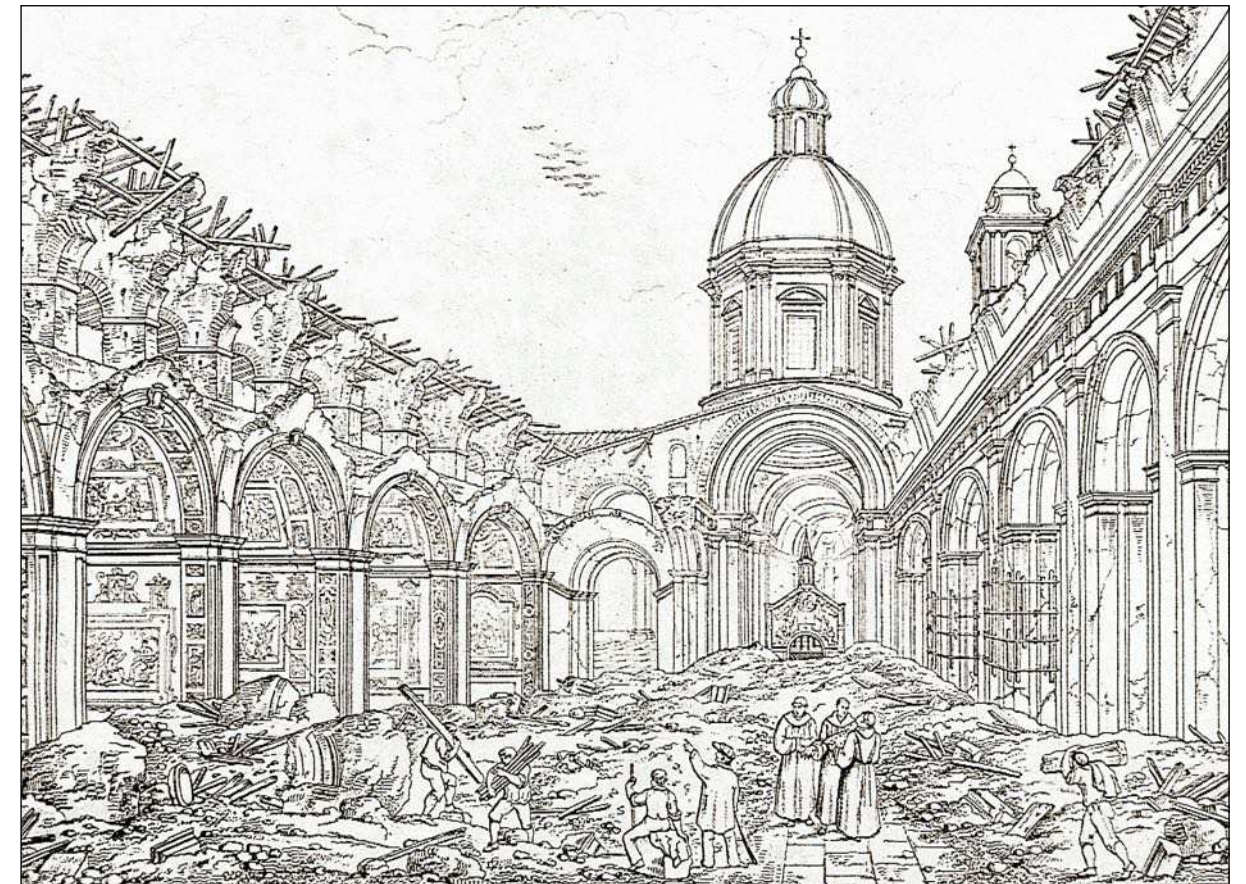
Fig.62 Basilica di Santa Maria degli Angeli: disegno del crollo della navata centrale e di quella di sinistra per il terremoto del 1832 (da Perilli 1842).
