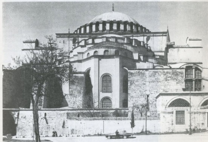
fig.57 Istanbul. Particolare dell'esterno della chiesa di S. Sofia con i contrafforti antisismici. I frequenti terremoti avvenuti a Costantinopoli danneggiarono ripetutamente il capolavoro di Antemio e Isidoro. I crolli furono dovuti sia all'eccessiva grandiosità del progetto, sia alla
