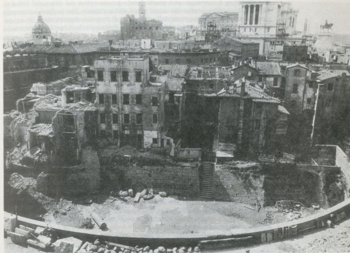
fig.66 Roma. Edifici in corso di demolizione tra l'emiciclo del Foro Traiano e via Alessandrina durante i lavori per l'apertura di via dei Fori Imperiali nel 1932-33. La fatiscenza e la vecchiezza
