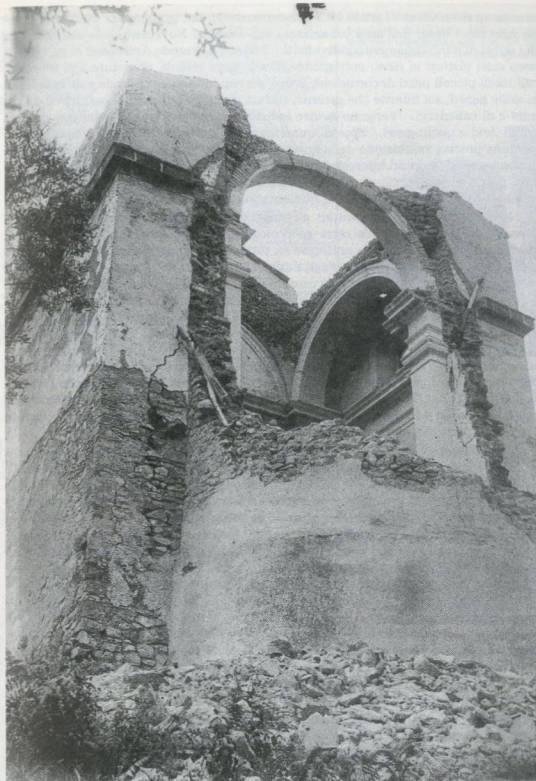
fig.71 Monte Porzio Catone. Crollo parziale della cappella del camposanto: i danni più gravi del terremoto del 19 luglio 1899 si ebbero nella zona di Frascati (Archivio Fotografico SGA).
