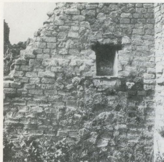
fig.89 Pompei. Casa dell'ultima epoca pompeiana in opus vittatum di tufo giallo flegreo (foto J.-P.Adam).
