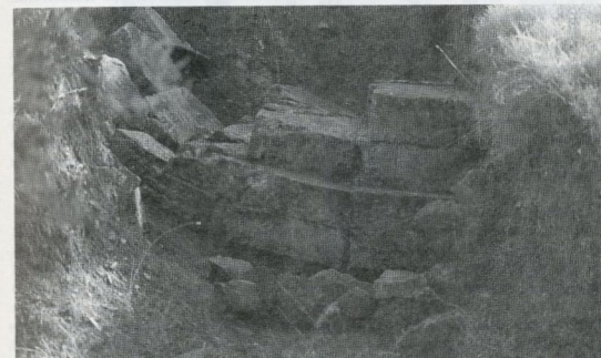
fig.195b Interpretazione della dislocazione della figura precedente: lo spostamento verso il basso può essere l'effetto cumulativo di diversi eventi sismici.
