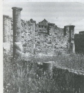
fig.239 Pompei. Mulino-panificio di Proculus (VII, 2, 3): il peristilio della casa fu occultato al momento della sua trasformazione in panificio (foto J.-P. Adam).
