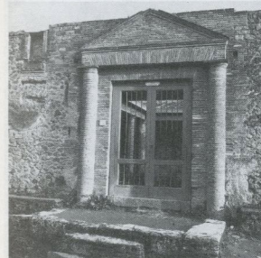
fig.234 Pompei. La facciata della casa di Marcus Lucretius (IX, 3, 5) fu rifatta in mattoni: la decorazione, forse persistente sull'intonaco, è stata sacrificata alla solidità dei due robusti contrafforti (foto J.-P. Adam).
