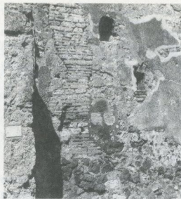
fig. 217 Pompei. Fessura in un muro in opus incertum (VI, 7, 5) richiusa con materiali di terracotta (mattoni e tegole) e pietre rettangolari (foto J.-P. Adam).
