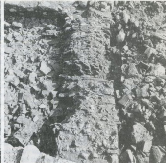
fig.267 Patti Marina. Peristilio della villa romana: il pilastro crollato dell'angolo sud ovest del portico.
