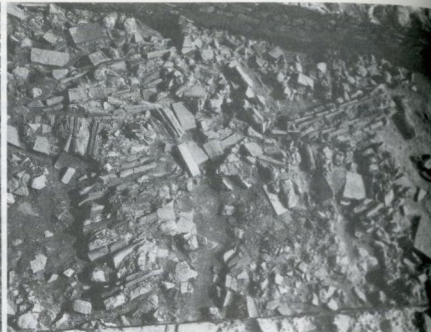
fig.265 Patti Marina. Peristilio della villa romana: particolare dei crolli. Si distinguono le strutture di due pilastri e di una parte degli archi che li collegavano.
