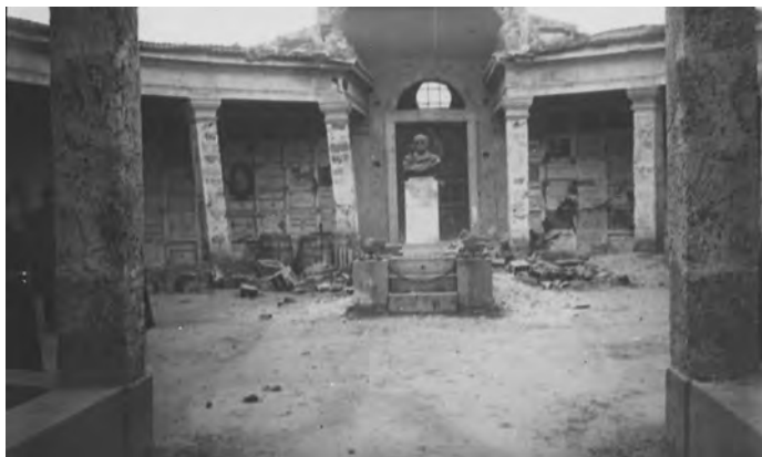
Fig. 21 – Cimitero di Sora: colonne dalla cui direzione di inclinazione Alfani trasse conferme sulla direzione di provenienza delle onde sismiche. Diapositiva n. 48 delle proiezioni di Alfani, reportage fotografico cit.
