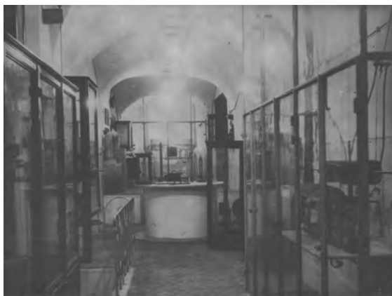
Fig. 9 – Veduta della stazione sismica sotterranea dell'Osservatorio Ximeniano realizzata da Alfani nei primi anni del '900 e costantemente aggiornata con gli strumenti più avanzati, spesso da lui progettati (lastra fotografica originale conservata nell'archivio della Fondazione Osservatorio Ximeniano di Firenze).
