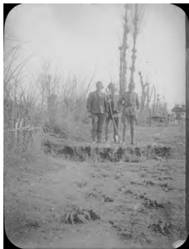
Fig. 25 – Soldati addetti al ripristino della transitabilità di una massicciata attraversata da una profonda spaccatura nel terreno. Diapositiva n. 39 delle proiezioni di Alfani, reportage fotografico cit.
