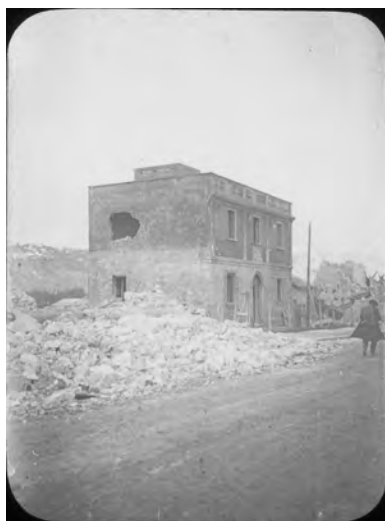
Fig. 27 – L'unica casa di Avezzano che si è salvata era in cemento armato. Il foro che si vede fu causato da una trave di una casa vicina crollata. Diapositiva n. 52 delle proiezioni di Alfani, reportage fotografico cit.
