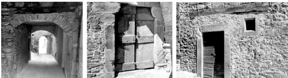
fig. 5 Da sinistra a destra: Tereglio (Lucca), un passaggio voltato costruito con elemento di rafforzamento fra due edifici; San Romano di Garfagnana (Lucca), le porte e le finestre sono delimitate da architravi e stipiti di pietra e legno; nella muratura sono inseriti elementi lignei.
