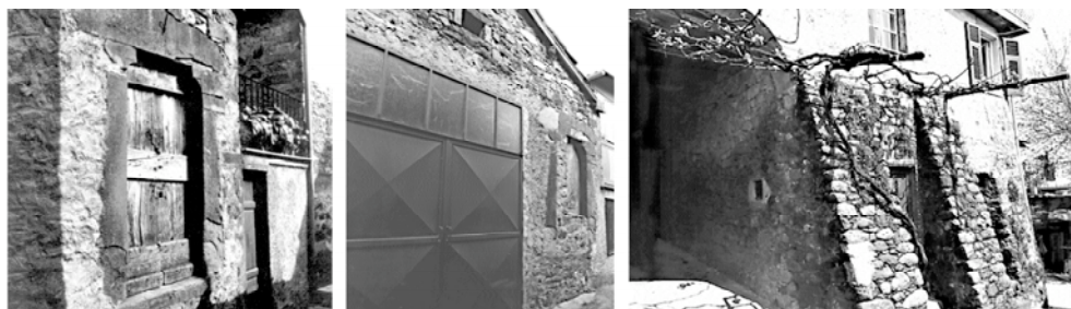
fig. 6 Da sinistra a destra: Albiano (Lucca), un edificio con un portasle come appariva nel 1972-73 e a fianco in una foto di vent'anni dopo. L'apertura del garage ha aumentato notevolmente la vulnerabilità dell'edificio; San Terenzo (La Spezia), tipici contrafforti in muratura per consolidare pareti dissestate.
